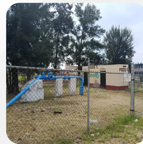
MANTENIMIENTO Y COLOCACION DE MALLA CICLONICA EN PREDIOS DONDE SE UBICAN LOS POZOS PROFUNDOS
