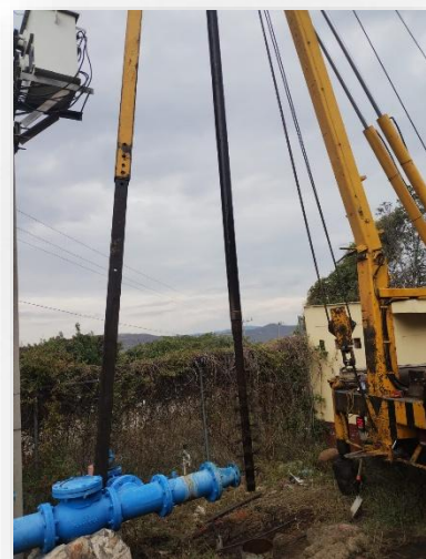
LIMPIEZA Y CEPILLADO DE BOMBA EN POZOS
