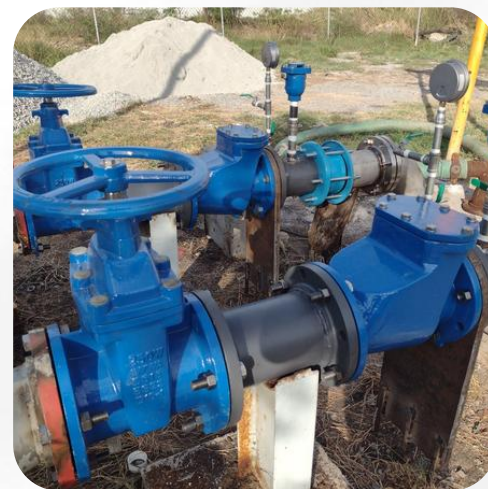
REHABILITACION CARCAMO EMERGENTE DE DEMASIA DE AGUA
